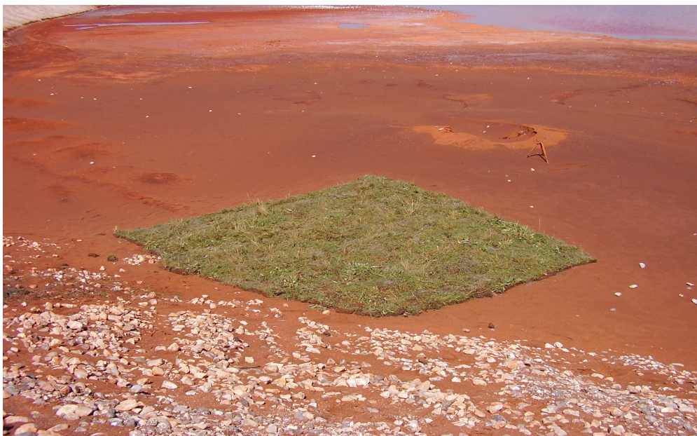
Фото. 5.5. Часть площадки шламохранилища, которая покрыта снятой дерниной
