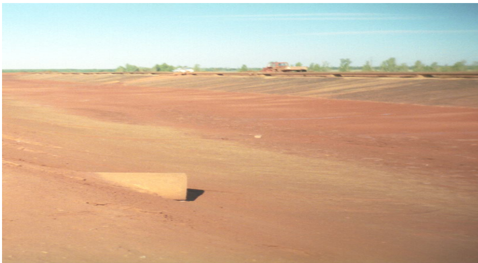
Фото 2. Часть рамки шламохранилища, планируемая для закрепления и пылеподавления.
