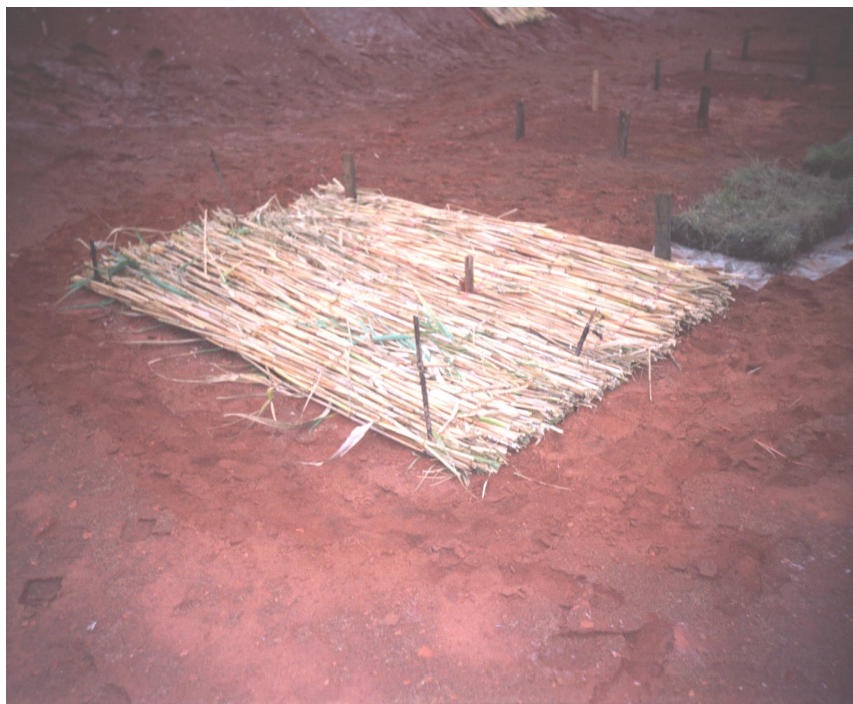
Фото 4. Тростниковые маты, уложенные на плоской части шламохранилища.
