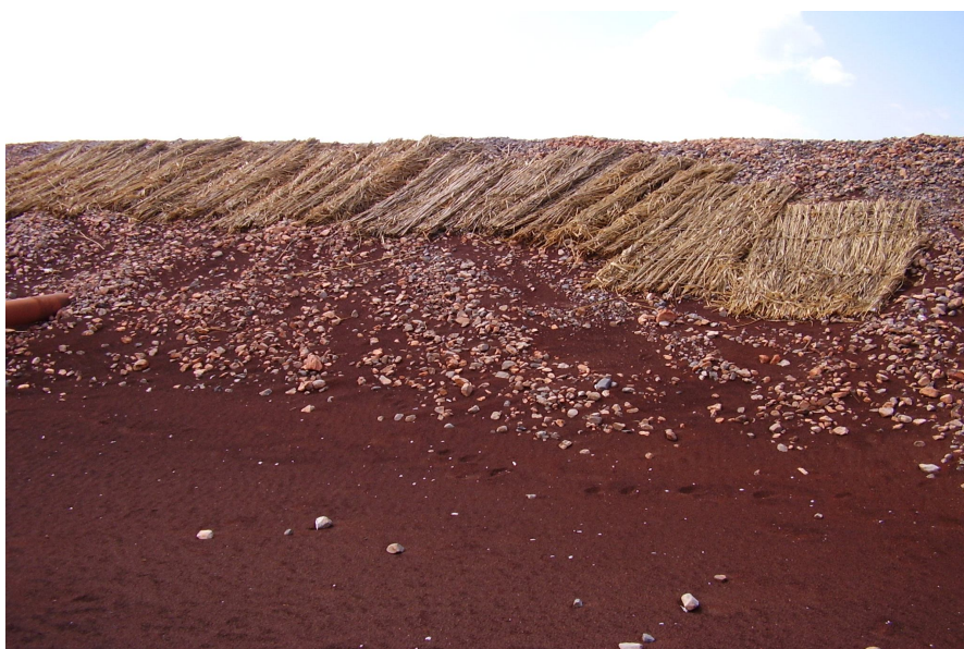
Фото 6. Размещение тростниковых матов на откосе шламохранилища.
