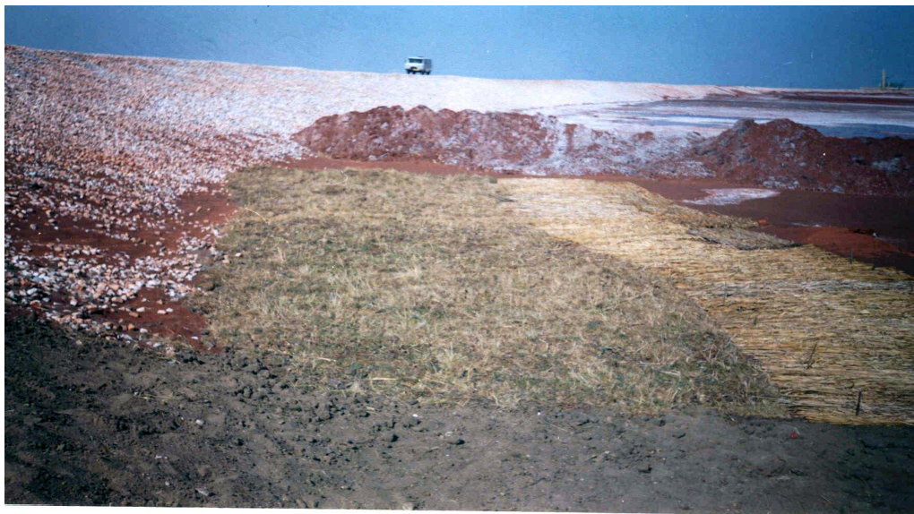
Фото 5.6. Конечный вид покрытия полигона дерниной и тростниковыми матами.
