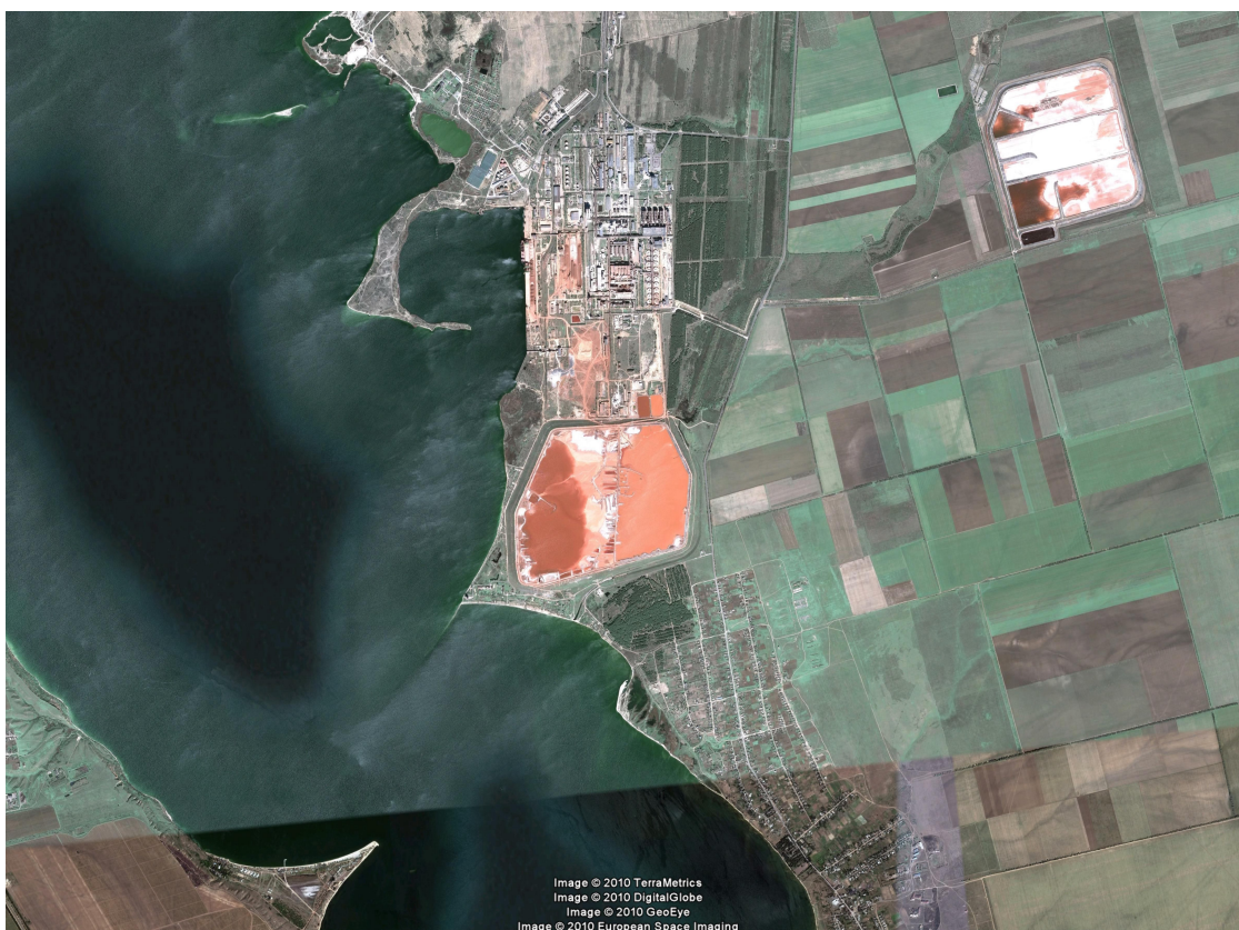
Фото 5.12. Крупный план НГЗ и хвостохранилища красных шламов.
